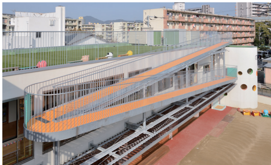
屋上園庭へのスロープ全景
